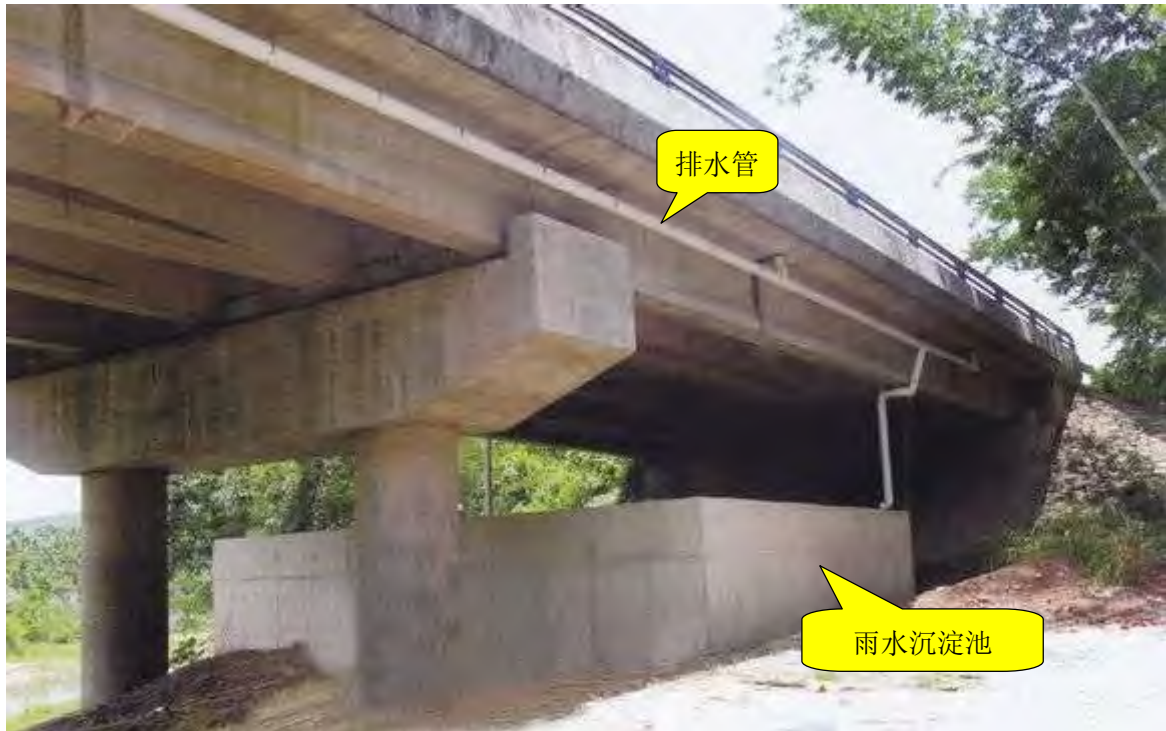
图 6.3-1 桥面径流收集及沉淀池示意图
